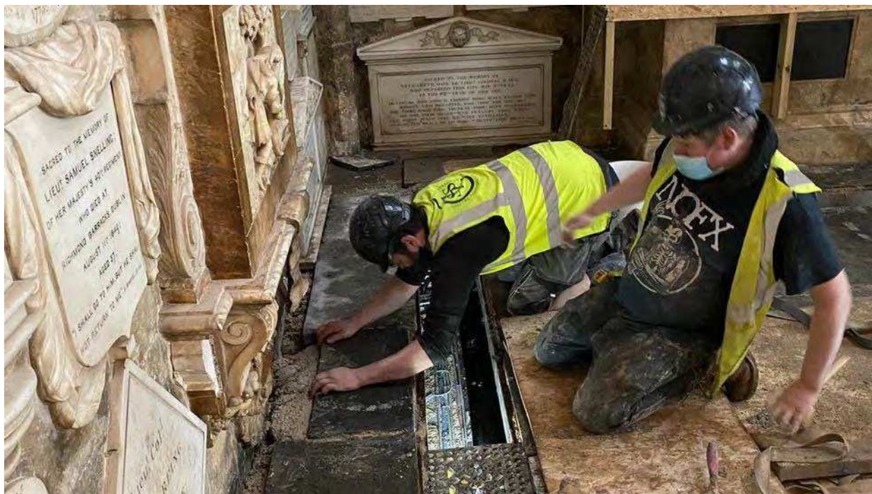
Figură 6. Operațiunile de restaurare a pardoselei. Sursa: www.bbc.com
